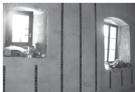
Rysunek 28 Railjet montaż listew (instalacja wykonana przez partnera Purmo we Wrocławiu)
