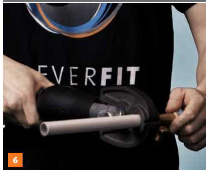
Zaprasowanie połączenia
