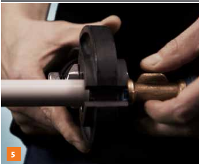
Dopasowanie złączki do szczęki typu TH
